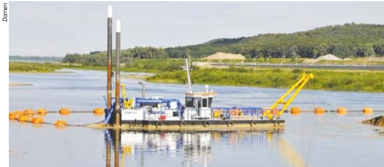
Equipamento adquirido pela Vale Verde é solução para dragar materiais em grandes profundidades
