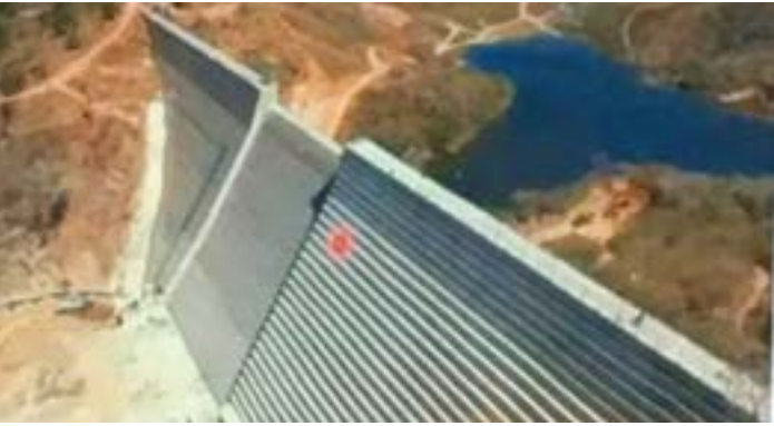
Contenção de concreto é a principal obra da Vale em Barão
