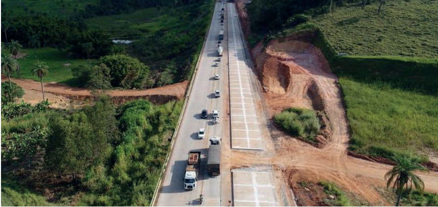
Lote entre Barão de Cocais e Caeté é um dos que ainda estão em obras na BR-381
