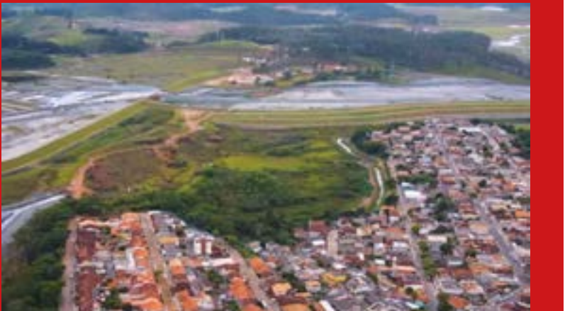
Vista parcial dos trechos dos bairros Bela Vista e Nova Vista, no entorno do Sistema Pontal
