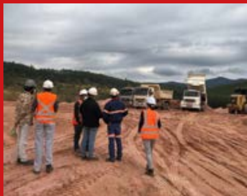
Obras de construção do Aterro Sanitário Intermunicipal, em Conceição do Mato Dentro
