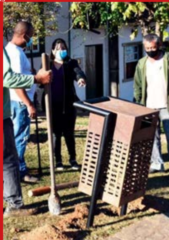
Instalação de lixeiras revitalizadas no centro histórico de Catas Altas
