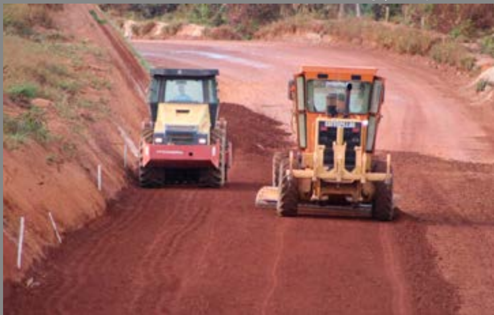
Pavimentação de trecho da MG-010, entre Conceição e Serro, deve ser finalizada em 2022
