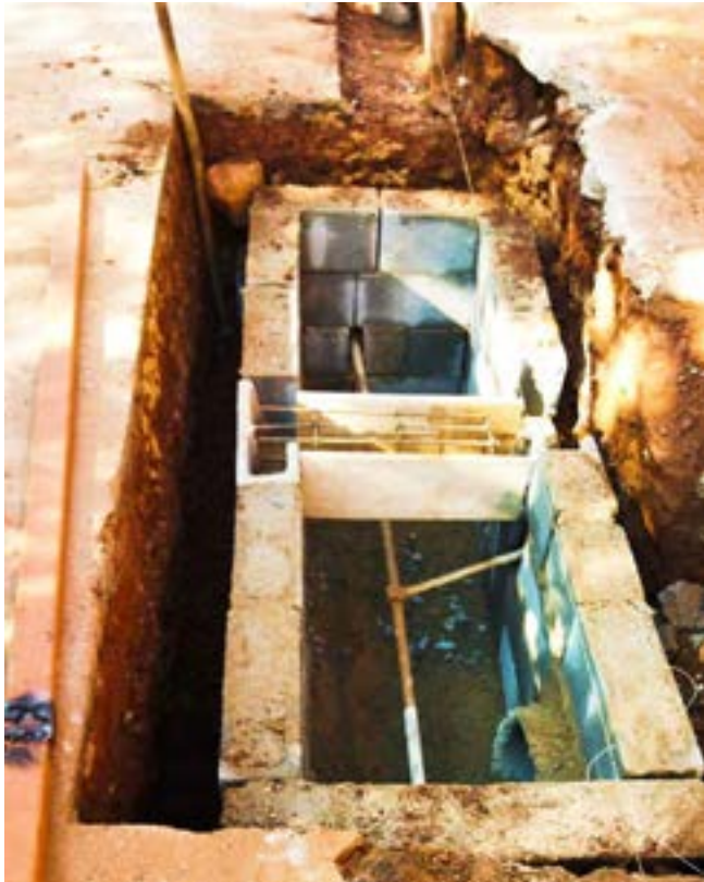
Rede de captação de água pluvial construída em Brumal, Santa Bárbara
