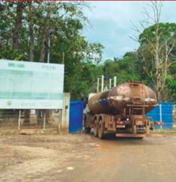
Caminhões-pipa chegando à ETA Gatos para realizar a entrega da água capta na barragem Santana
