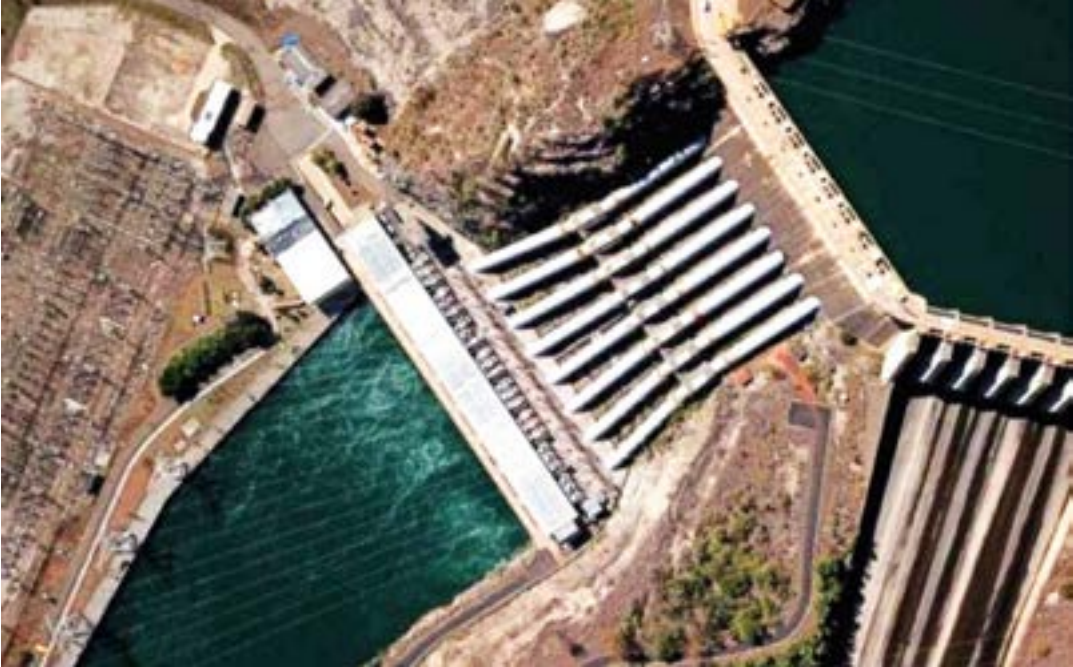
Usina de Furnas, uma das maiores de Minas Gerais
