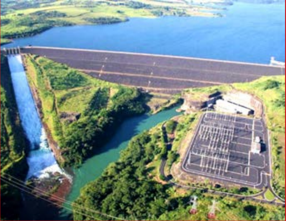
Usina Hidrelétrica de Ponte Nova
