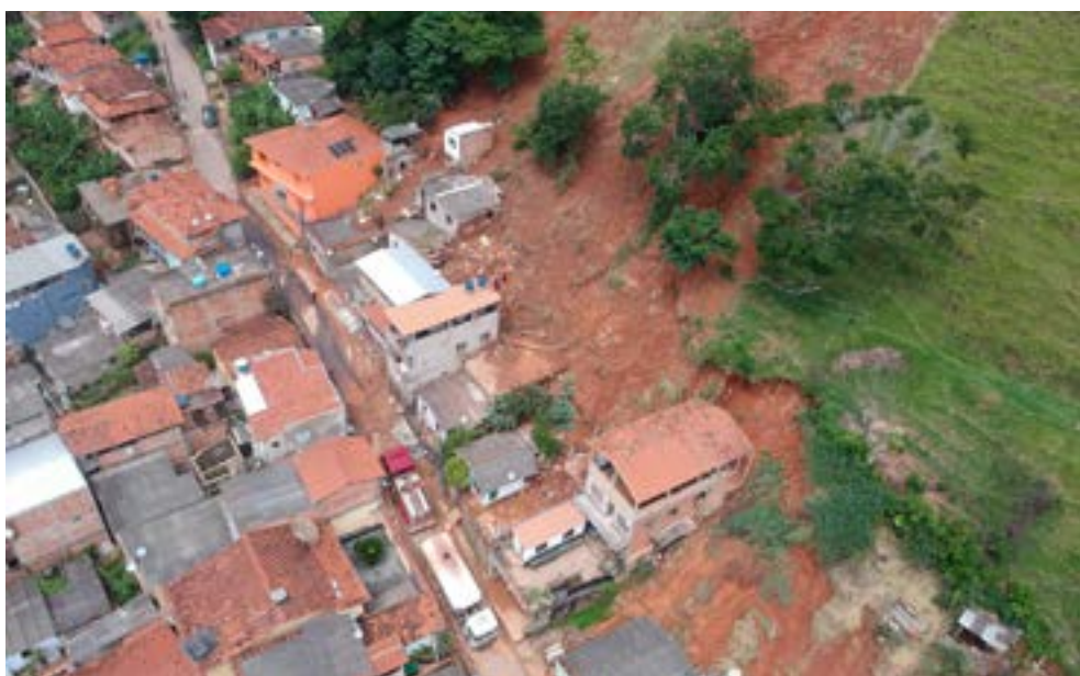
Deslizamento de terra que soterrou cinco pessoas no bairro do Poção
