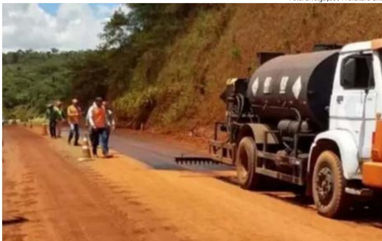
Obras da estrada do Serro já estão em fase final
