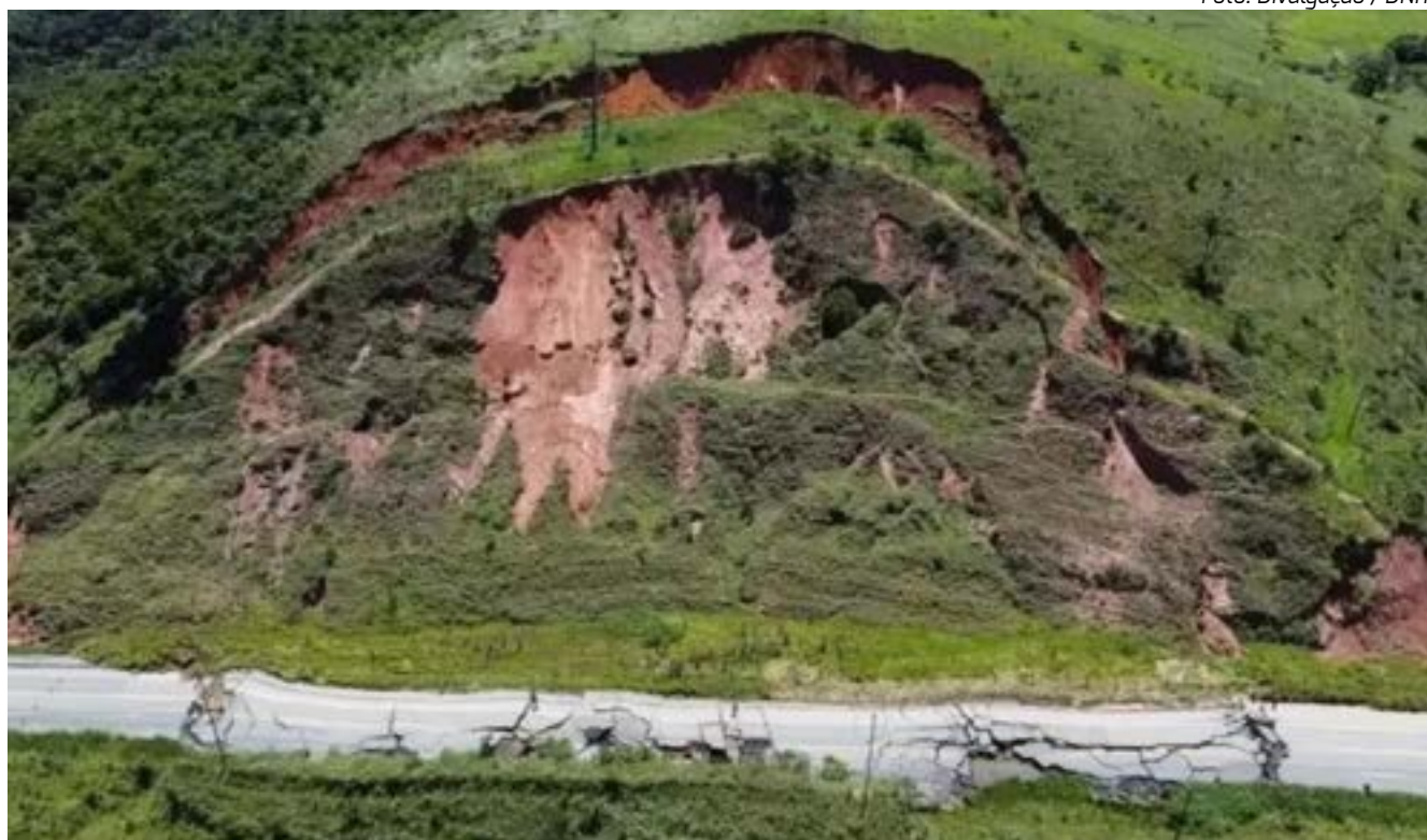
Vista aérea da encosta que desabou, forçando a base da pista e causando o estufamento
