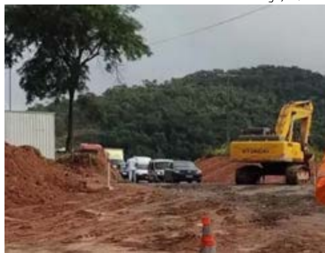
Obras de liberação do desvio, construído ao lado do trecho interditado
