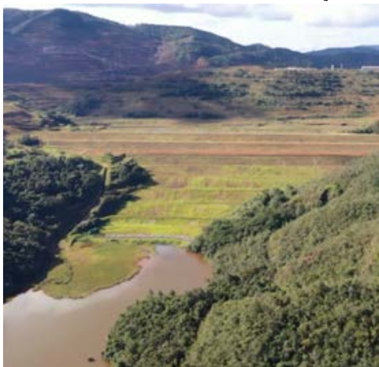
Barragem Sul Superior - Gongo Soco, em Barão de Cocais
