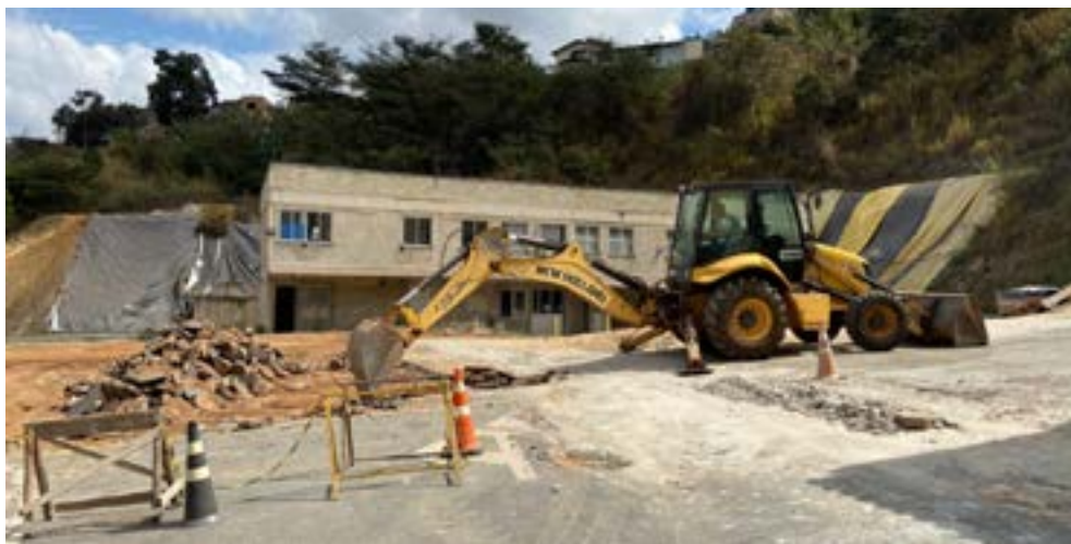
Preparação do terreno para receber obras da unidade de radioterapia
