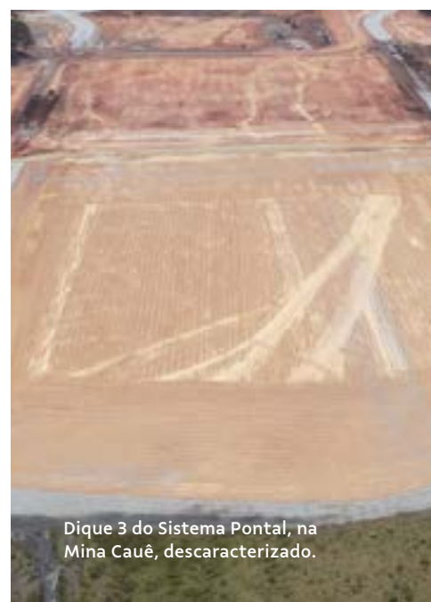
Barragem Ipoema, na Mina do Meio, descaracterizada.
