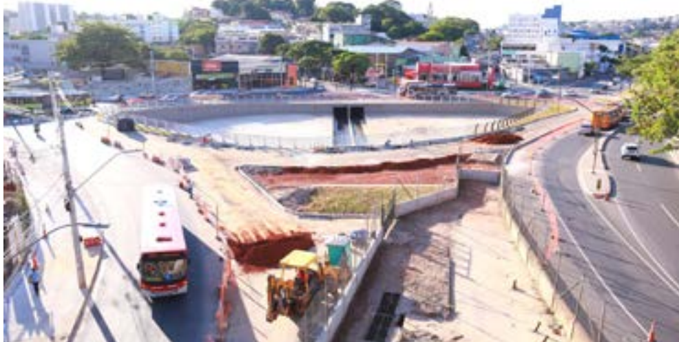
Vilarinho, na região de Venda Nova, recebe obras de intervenção em preparação para o período chuvoso.
