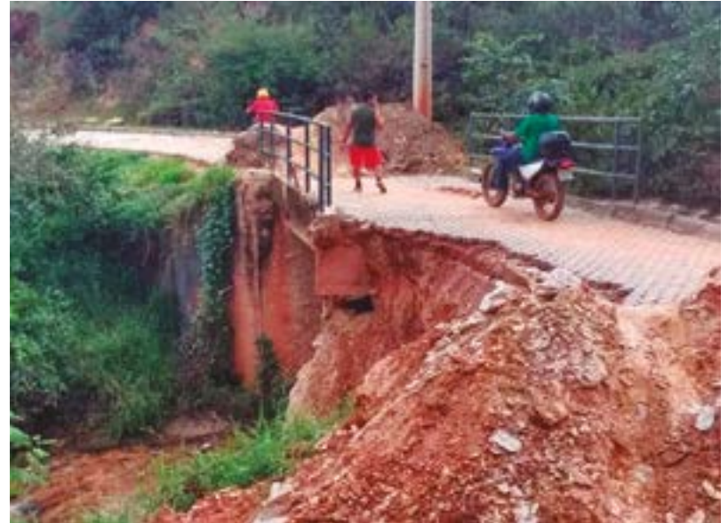
Neste ano, foram feitas obras de contenção de encostas e melhorias nas redes de captação pluvial para enfrentar o período chuvoso
