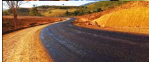
Pavimentação nas estradas dos distritos
