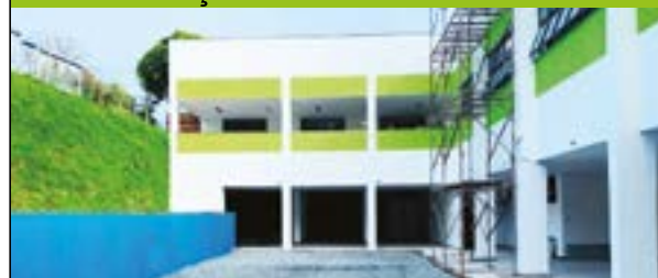
Obras na creche Irmã Helena
