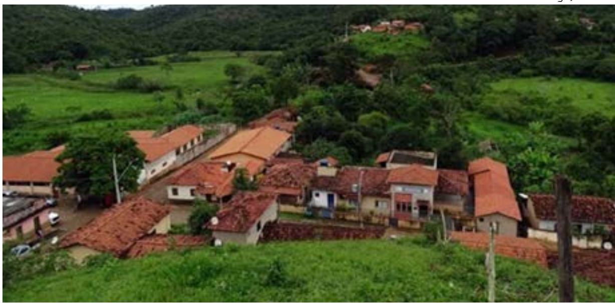
Comunidade São José do Jassém, na região de Conceição do Mato Dentro e Alvorada de Minas, será uma das localidades reassentadas
